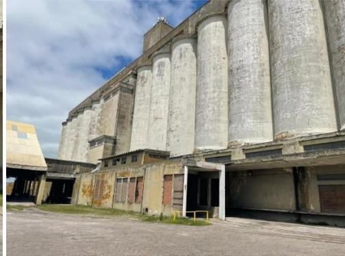
m) Vista dos silos, tombador e estação de carregamento e descarregamento de caminhão
